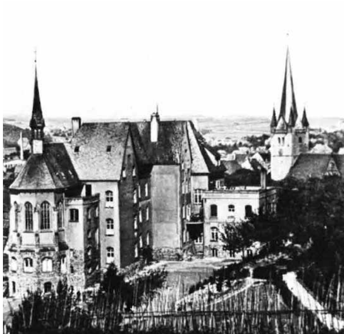
Het "alte Krankenhaus" in Menden.
