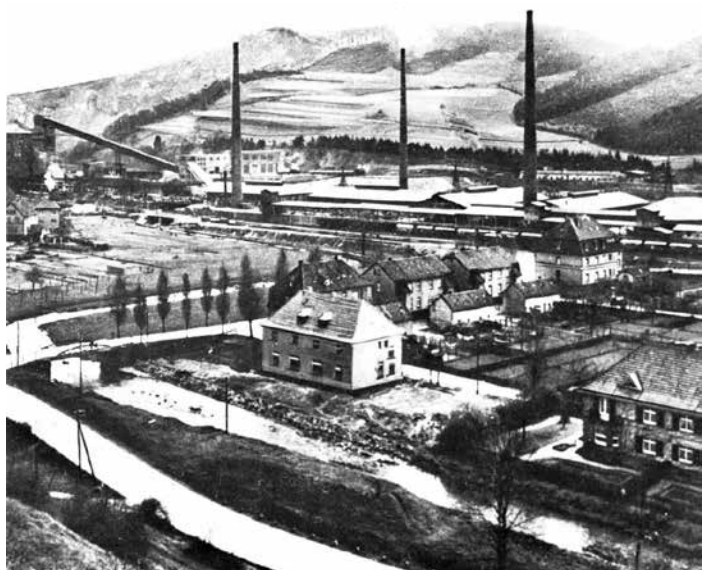
De kalkfabriek van Oberrödinghausen.
